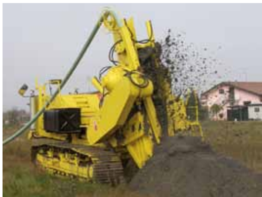
Schema di posa del dreno orizzontale collegato alla pompa Varisco
