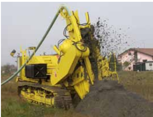
Schema di posa del dreno orizzontale collegato alla pompa Varisco
